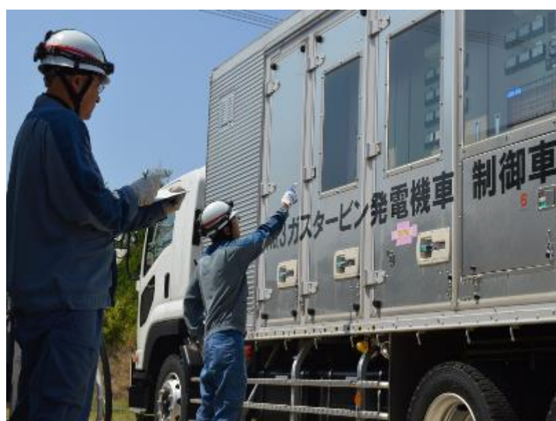
電源供給訓練
